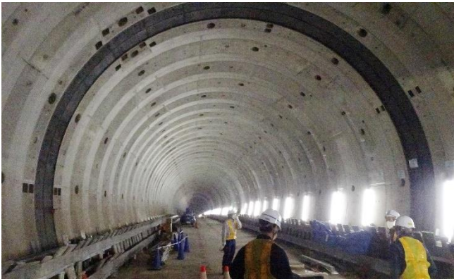
難工事だった「新横浜トンネル」も昨年11月に貫通した(4月撮影)
